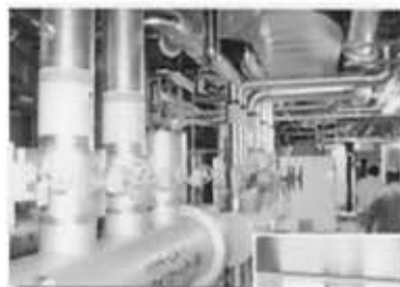
大学院大学機械室
