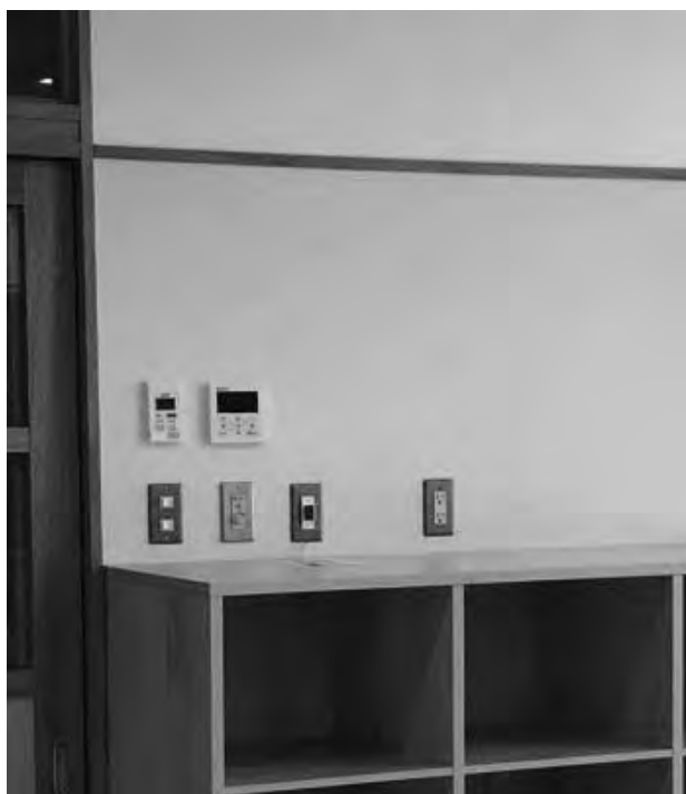
特別教室内 照明スイッチ・アッテネーター・非常用押釦 コンセント設置状況
