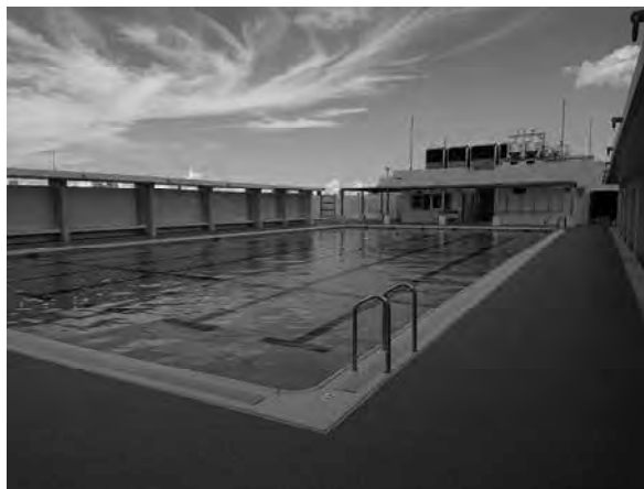
高学年用プール右奥が機械室
