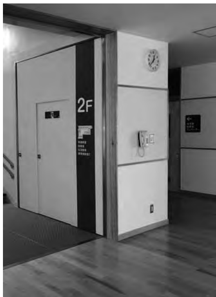
廊下電話設置状況
