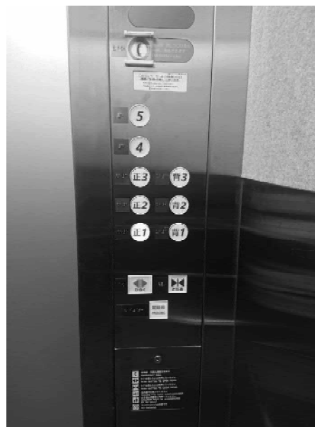
人荷共用兼車いす用エレベータ 両側出入口配膳と乗用を兼用している。
