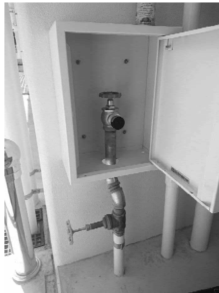
屋上プールより専用の消火用と災害時の採水口を設置
