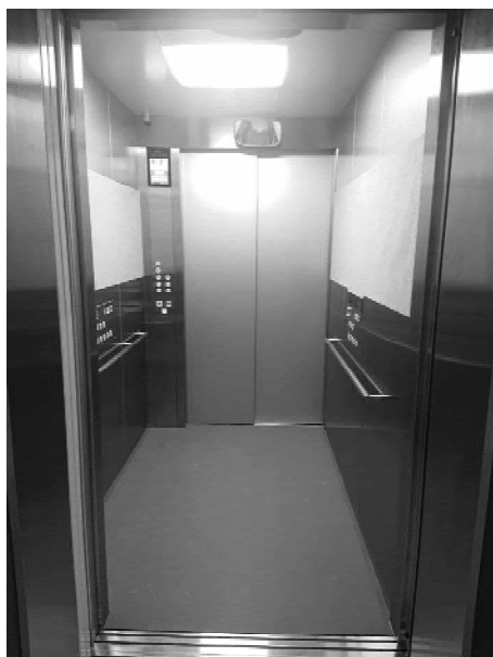
人荷共用兼車いす用エレベータ 両側出入口配膳と乗用を兼用している。
